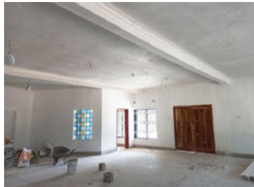
Ośrodek rehabilitacyjny w Lusace - prace wewnętrzne
